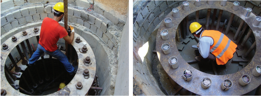
Şekil 11. Çelik Kolonların Monte Edilmesi
