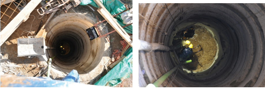
Şekil 8. Kuyu Temel İnşaatı Çalışmaları
