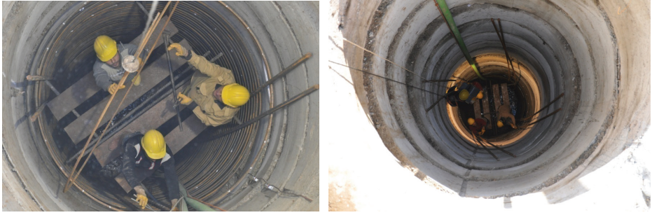
Şekil 10. Kuyu Temellerin İçine Bağlanan Demirler
